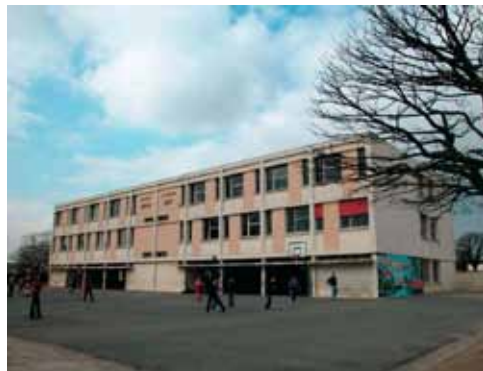
Reconstruction d'une école à Niort (79)
