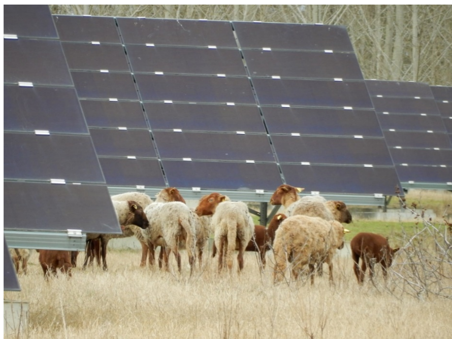
Exemple de la centrale photovoltaïque au sol de Casteljaloux (47) – complémentarité entre pâturage d'ovins et photovoltaïque (source JPEE)
