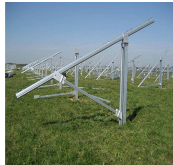
Exemple de structures et fondations envisagées
