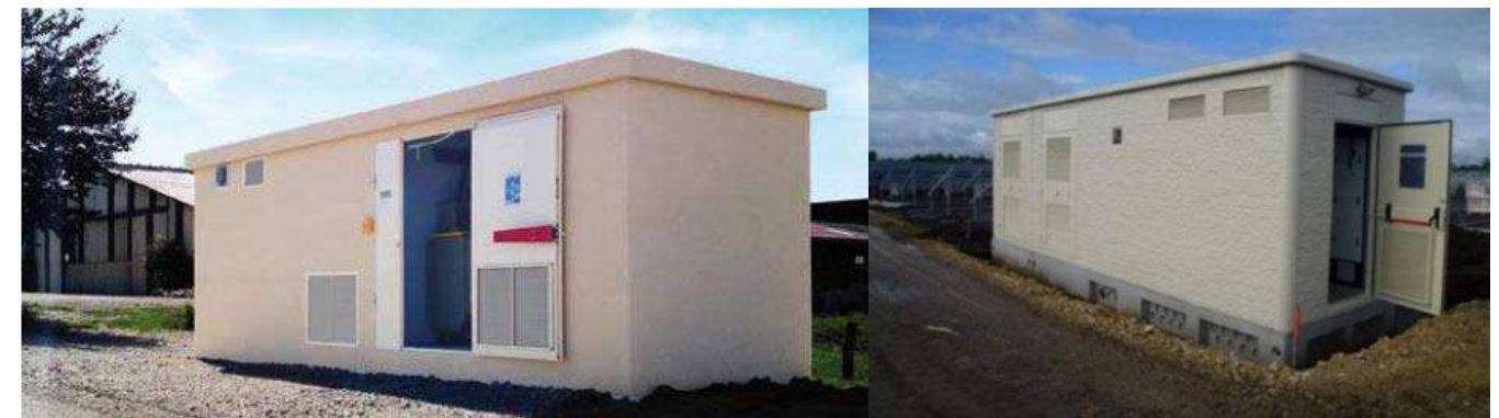
Photo 112 : Exemples de locaux techniques abritant les postes de transformation
