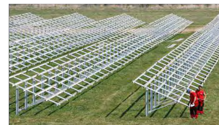
Photo 104 : Exemple de châssis fixes orientés sud
