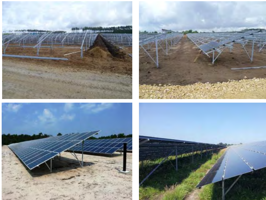
Photo 106 : Exemples de structures porteuses
