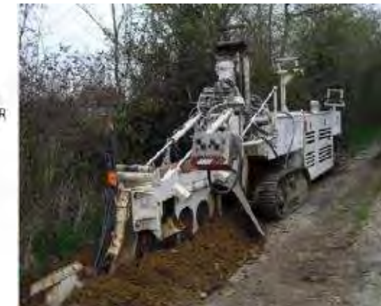
Photo 111 : Vue en coupe d'une tranchée et exemple de réalisation d'une tranchée de câbles
