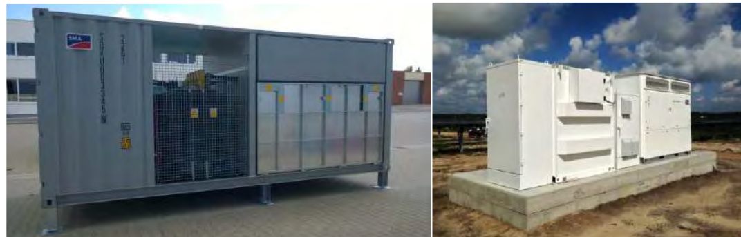
Photo 113 : Exemples de postes de transformation « container » ou « outdoor »
