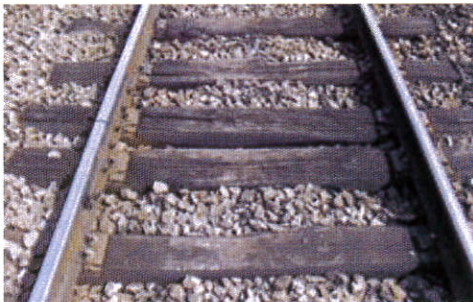
Rails courts sur traverses bois
