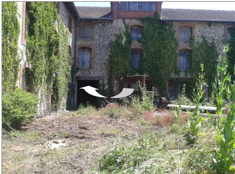
Fig. 3 : Accès principal au bâtiment pour le Grand murin et la Barbastelle
