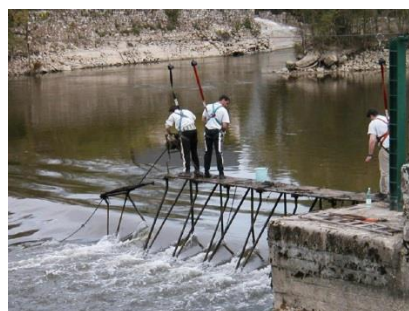
Remontée d'un tablier au barrage de Nitray (crédit : Syndicat du Cher canalisé)
