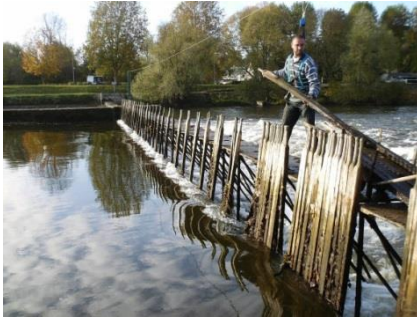
Manœuvre des aiguilles au barrage de Bléré. (crédit : Syndicat du Cher canalisé)
