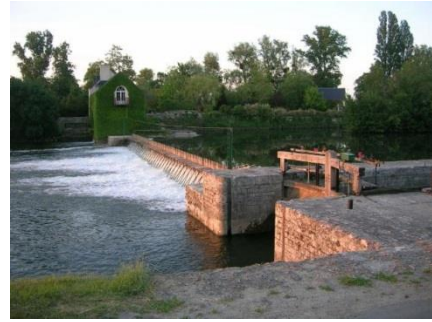
Barrage à aiguilles remonté (crédit : Syndicat du Cher canalisé)
