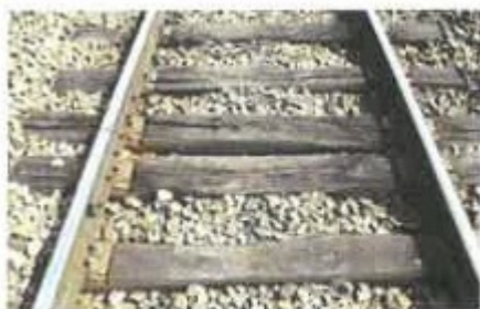
Rails courts sur traverses bois
