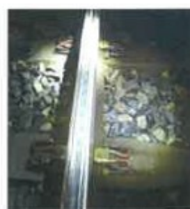
rail après meulage
