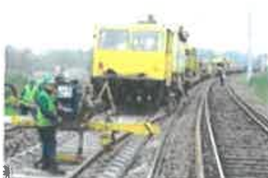
Longs Rails soudés sur traverses béton
