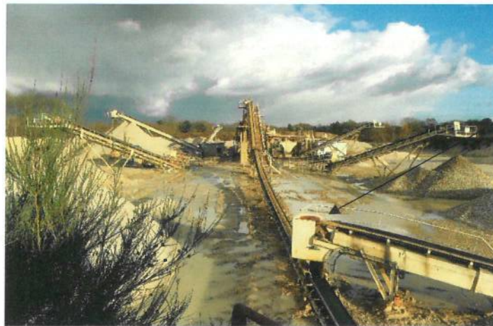
Arrivée du convoyeur à bande vers l'installation
