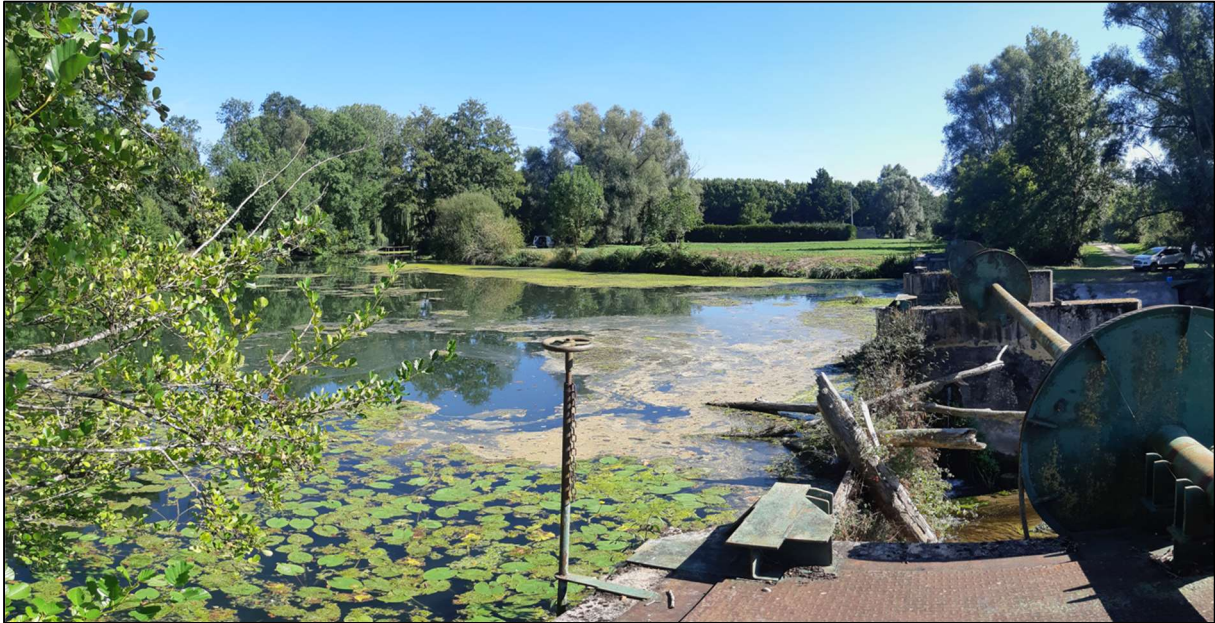
Figure 7 : Vue vers l'amont depuis le seuil (source : MTBE, 2022).
