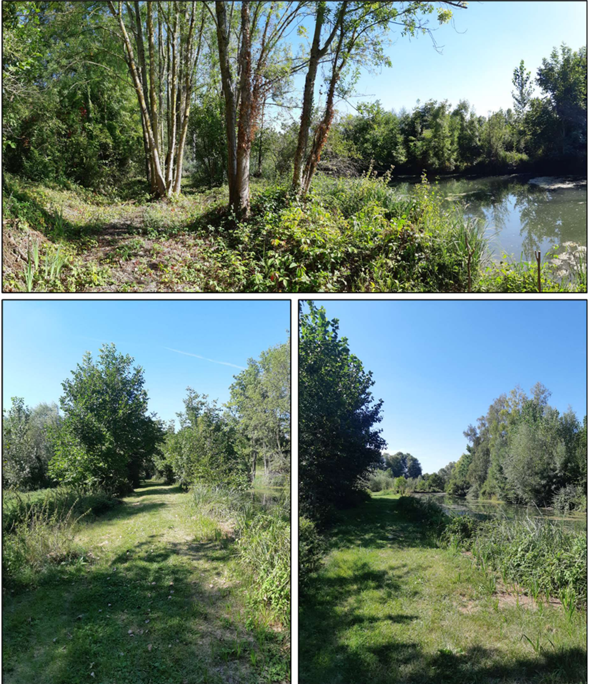
Figure 8 : Vue vers le bief d'amenée à la centrale existante ; haut : rive droite, bas : rive gauche (source : MTBE, 2022).
