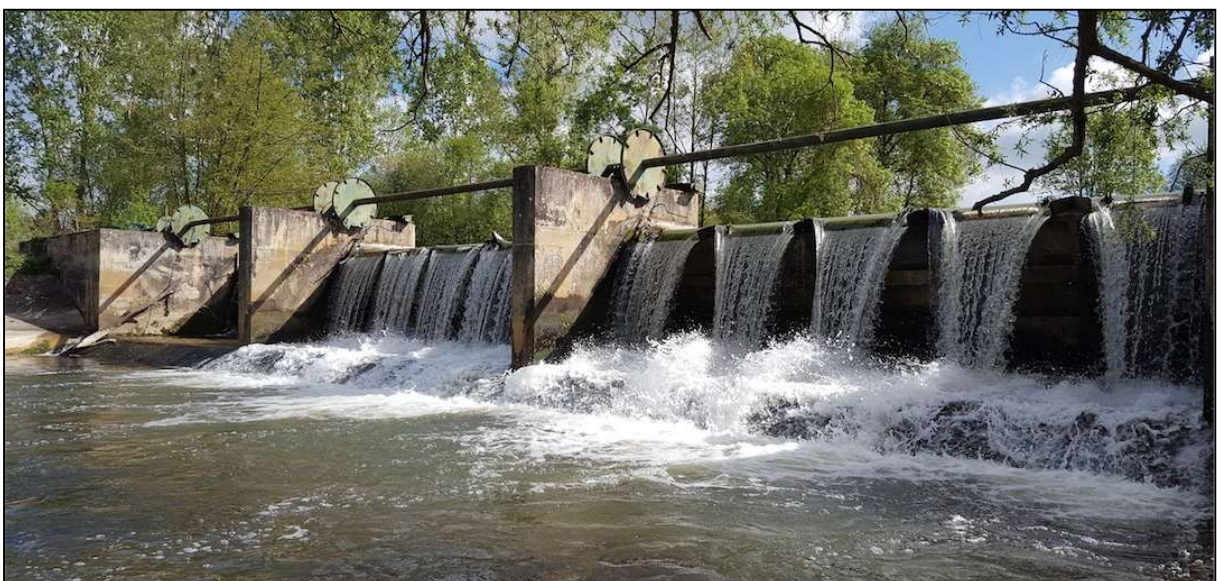
Figure 3 : Vue vers le barrage et les trois vannes (source : Aubry & Associés, nd.).
