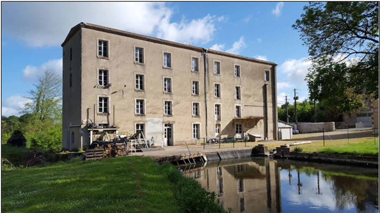
Figure 2 : Vue vers la centrale actuelle (source : Aubry & Associés, nd).
