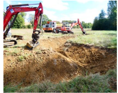
Remise en fond de vallée SIVY - 2019
