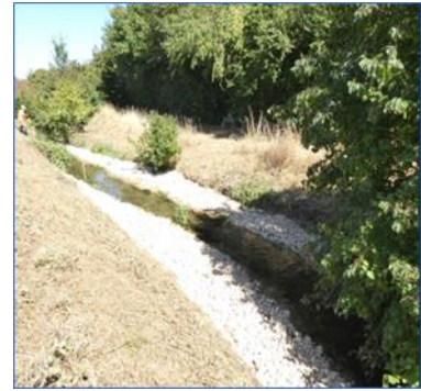
Exemple d'une recharge granulométrique (SIVY, 2020)
