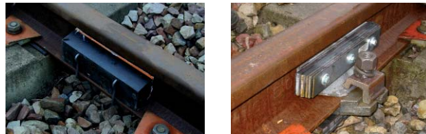
Exemples d'absorbeurs sur rail (Corus et Socitec)
