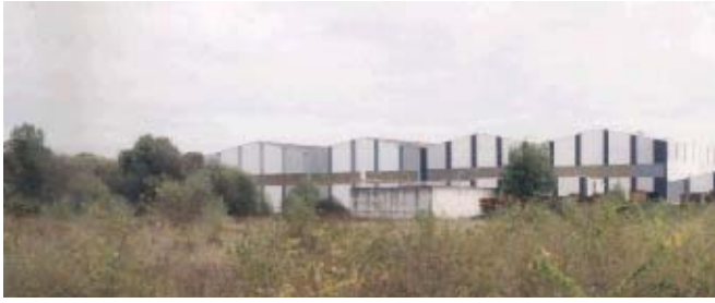
L'usine Rosière dans le fond de la vallée
