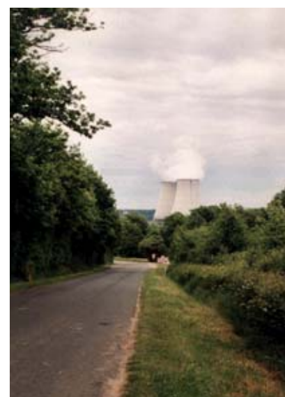
La centrale électronucléaire de Belleville-sur-Loire
