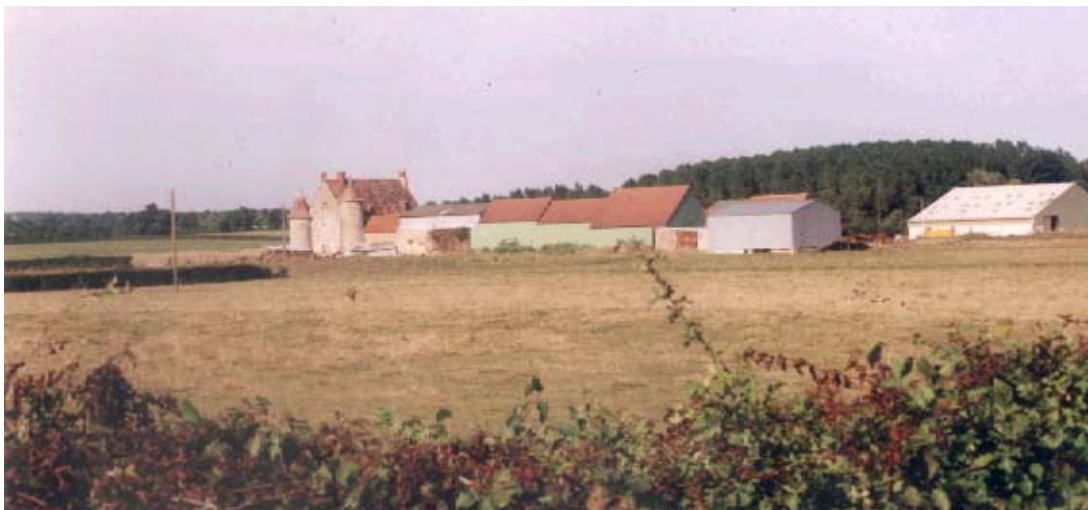
Bâtiments récents accolés à la ferme manoir de la Salle
