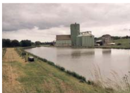
Le silo sur le canal, une coloration verte peu amène.
