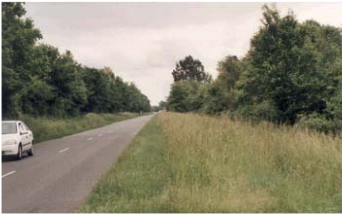
La route sur la «levée» de la Loire
